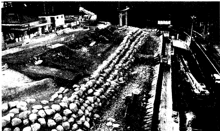
解体中の現理垣と背面の「階段状石列」
